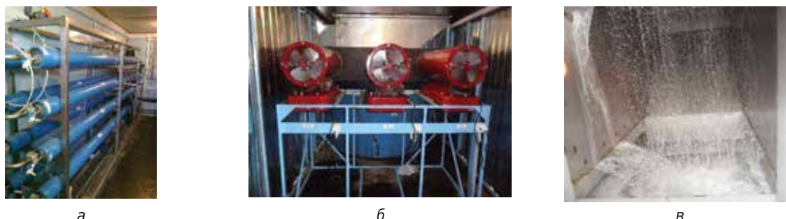
Рис. 6. а-модуль обратноосмотического опреснения, б- испарительный модуль, в-циркуляция концентрата в испарительной камере
